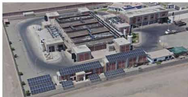
La planta de agua peruana de La Chira, construida por Acciona, usará energía fotovoltaica para operar
